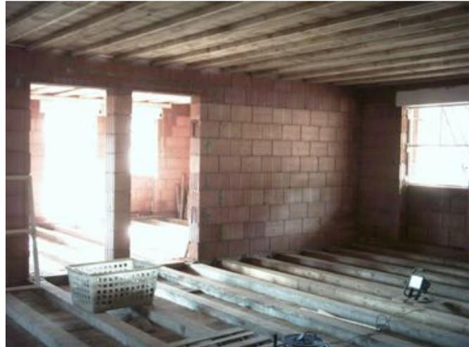
*Decken und Unterböden aus Holz, Mauern aus Tonziegel*
